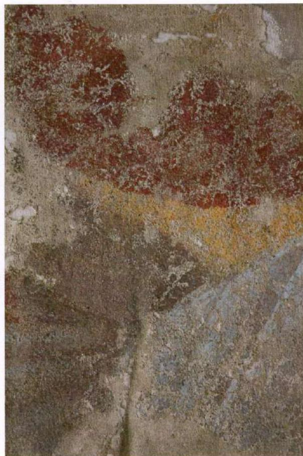
*Depositi superficiali, abrasione del film pittorico e crettatura degli strati di intonaco rimanenti*
